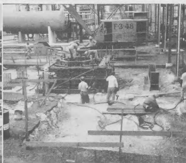
FUNDESHINAN TA worde prepará na AAR-1 y NFAR pa instalacion di dos tower, uno pa debutanizá y e otro pa depropanizá gasolin.
